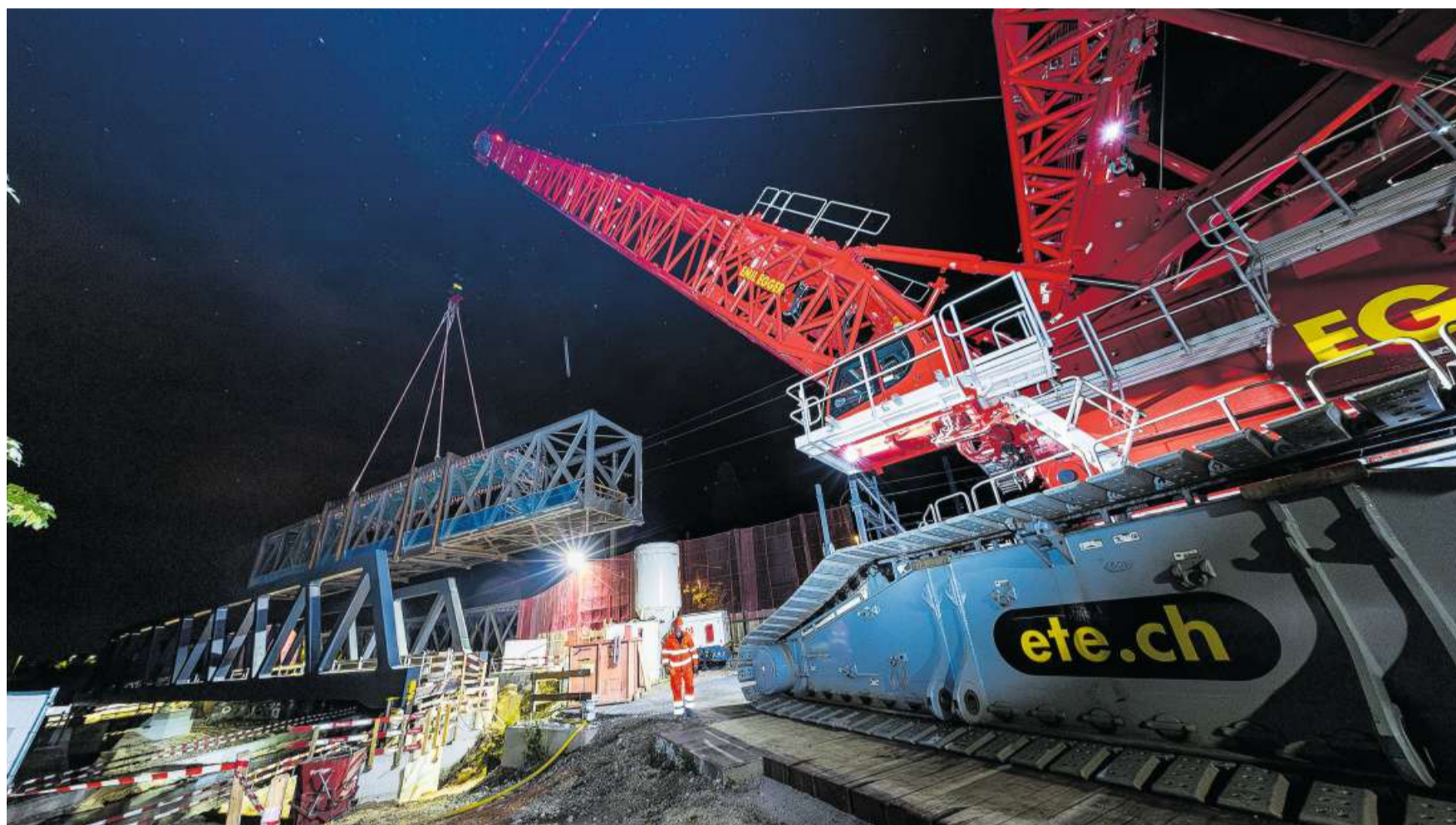
Alte Bahnbrücken in Münchenstein werden durch zwei neue Stahlfachwerkbrücken ersetzt – mitten in der Nacht während einer Bahnbetriebspause. Bild: Kenneth Nars
